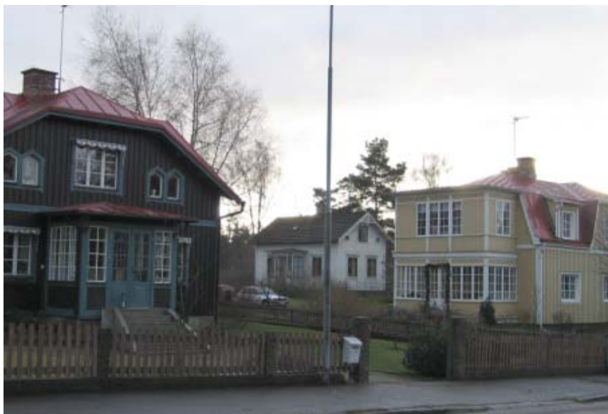
Pukebergsgatan, kvarteret Ejdern.
