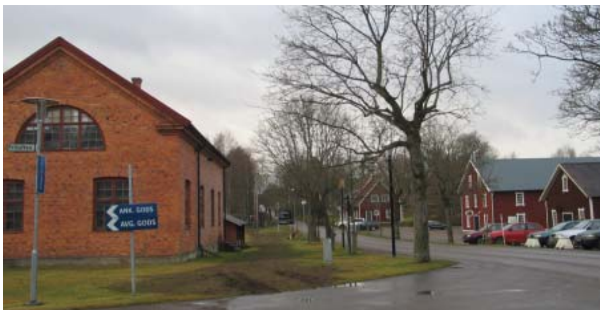
Bruksområdet med verks- och magasinsbyggnader.
