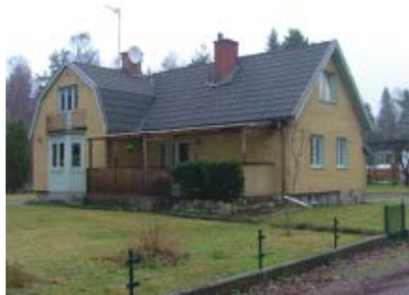
Bolmörten 5, sannolikt döljs en gamla stuga under den moderna fasadkostymen.
