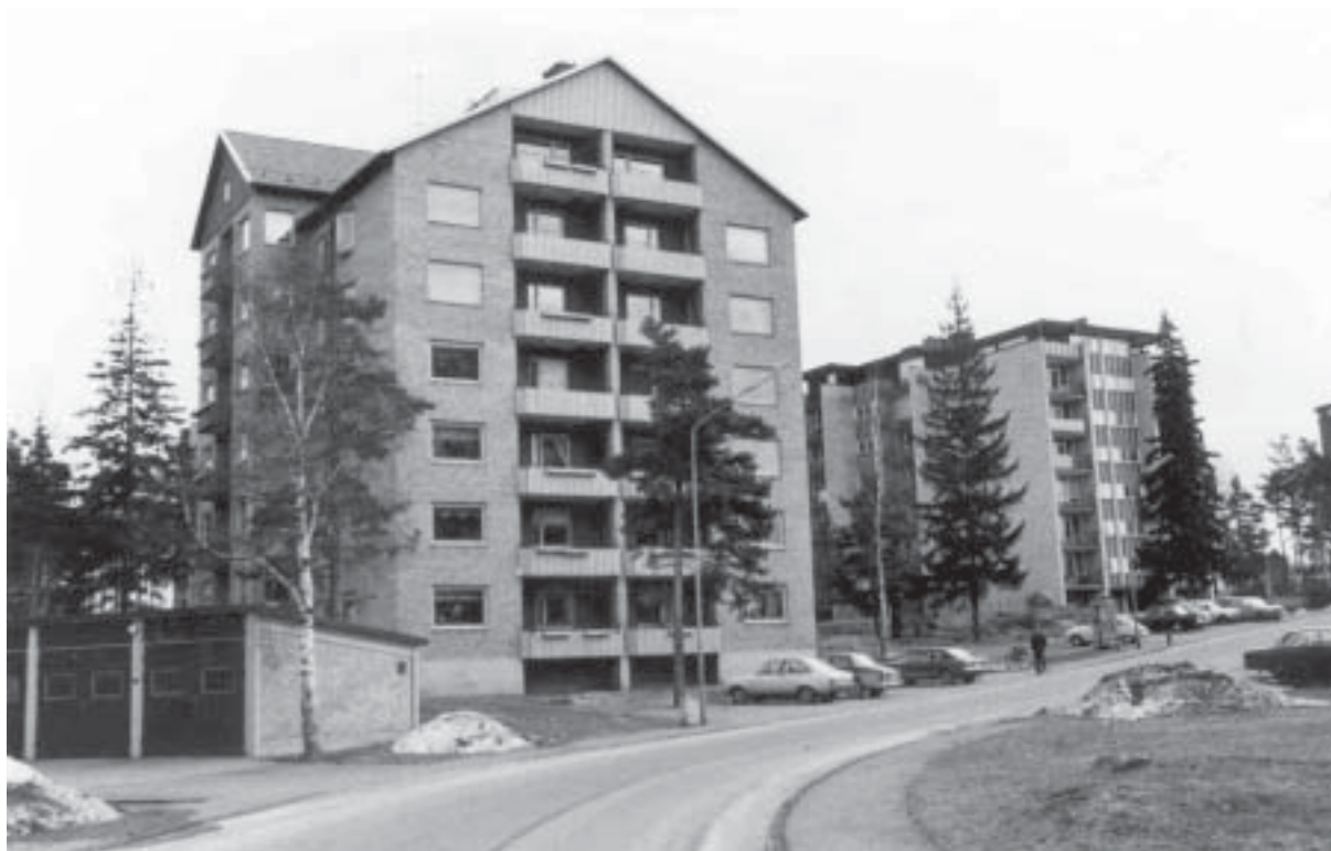
Punkthusen på Dahlborgsgatan på ett fotografi taget år 1979. Det främre punkthuset byggdes år 1958, det bakre år 1960.
